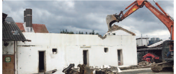
Der gesamte Betrieb von Familie Posch wurde umfang- reich saniert und neu gestaltet.
