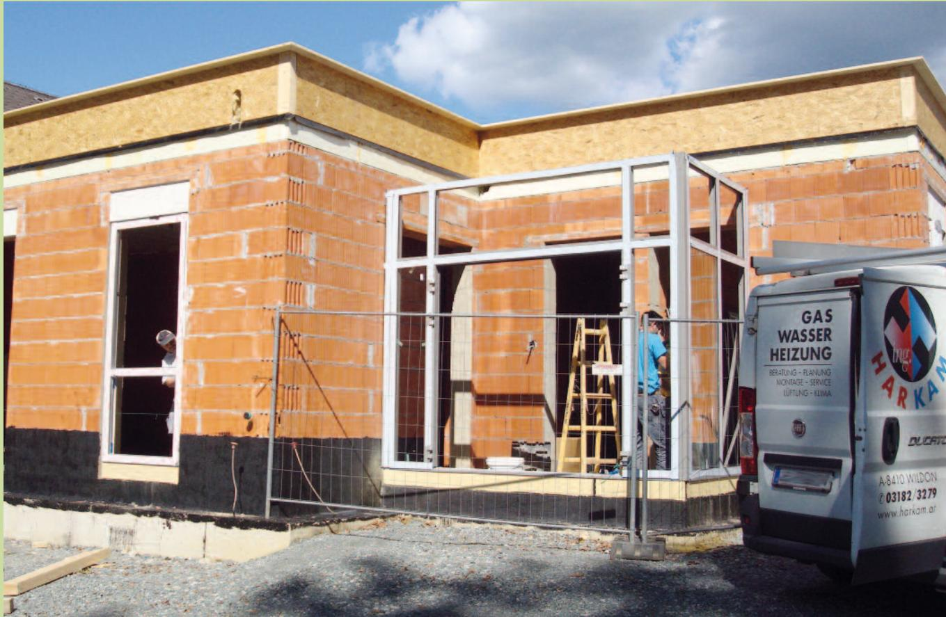
Die Arbeiten am Zubau zur Schutzengelhalle gehen trotz des teilweise regnerischen Wetters zügig voran. Derzeit wird der Rohbau fertig gestellt, Fenster und Türen eingebaut und die Sanitäreinrichtungen installiert. Die Zuleitungen für Wasser, Strom und Heizung wurden schon verlegt, während das Isoliermaterial für die Decke gerade angeliefert wird. Einziges Hindernis ist jetzt noch der Durchbruch zur bestehenden Turnhalle, der in den nächsten Tagen erfolgen wird.
